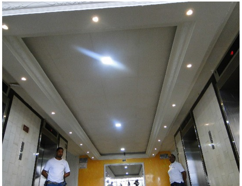
INSTALACION DE LUCES MICROLED
