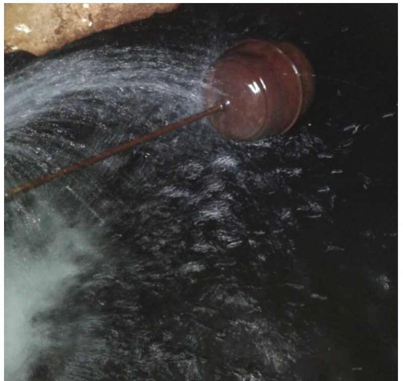
INSTALACION FLOTADOR TANQUES DE AGUA
