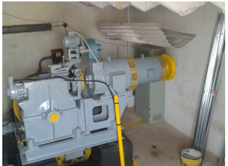
MODERNIZACION Y REPARACION DE MOTOR DE ASCENSOR DE SERVICIO
